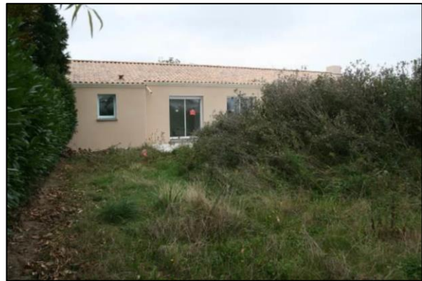
Pavillon en cours de construction
